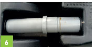
Attention : Ne pas chercher l'horizontalité de ces tuyaux : Une pente supérieure à 2% permet l'écoulement gravitaire entre la fosse toutes eaux et le filtre compact.
