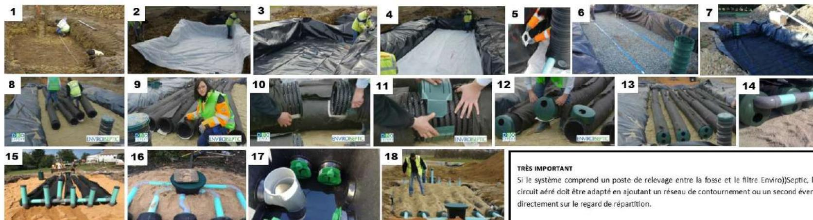
1- Préparer le sol récepteur en le mettant à niveau et retirer tout objet pointu du fond de la fouille.
