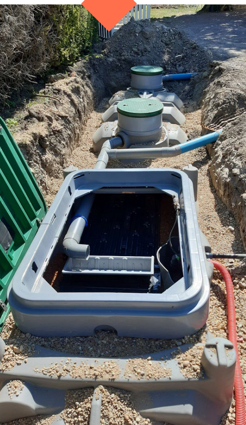
Installation d'ANC chez un particulier Source : SATESE 37
