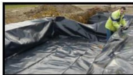
Déployer et positionner votre film PE 400 µm réel sur l'ensemble de la surface.
