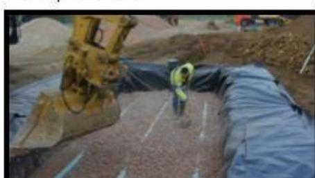
Comblir de 10 cm de gravier stable à l'eau de diamètre 10/40 mm.
