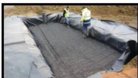
Recouvrir le gravier avec la grille de filtration (géogrid)
