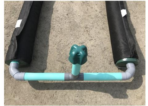
A l'extrémité du filtre, positionner la ventilation dans l'ouverture de l'adaptateur positionnée vers le haut.
