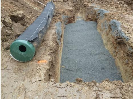
Préparer les tranchées selon les plans puis déposer 15 cm de sable filtrant de niveau.
