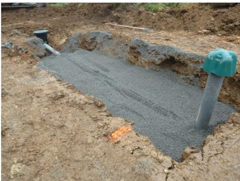
Recouvrir de sable filtrant sur une hauteur de 10 cm sur les conduites Enviro)) Septic. Terminer par la pose d'une couche de remblai perméable à l'air.
