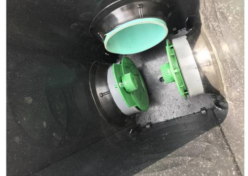
Emboîter les égalisateurs à l'intérieur du regard. Ajuster les égalisateurs à l'aide des molettes de façon à ce que les vannes soient en position haute.
