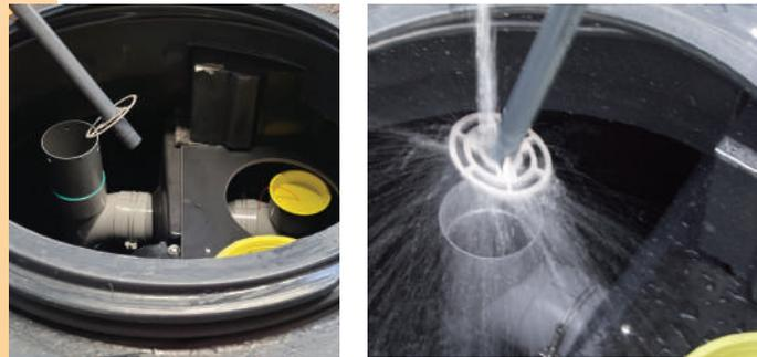
La mesure annuelle de la hauteur des boues (**1**) est nécessaire. La vidange doit être réalisée lorsque les boues atteignent 30% du volume du compartiment prétraitement. Cette prestation de mesure est comprise dans le contrat de maintenance.
