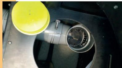
Vérifier que les 2 bouchons plastique sur la plaque PVC sont bien emboîtés pour confiner les médias Sebiflow dans le réacteur.
